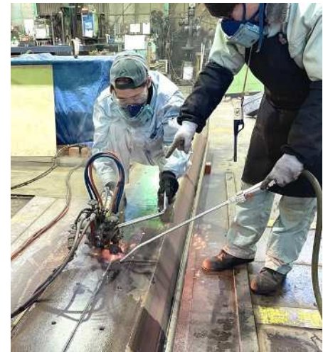
ガス切断中の須山(左)
